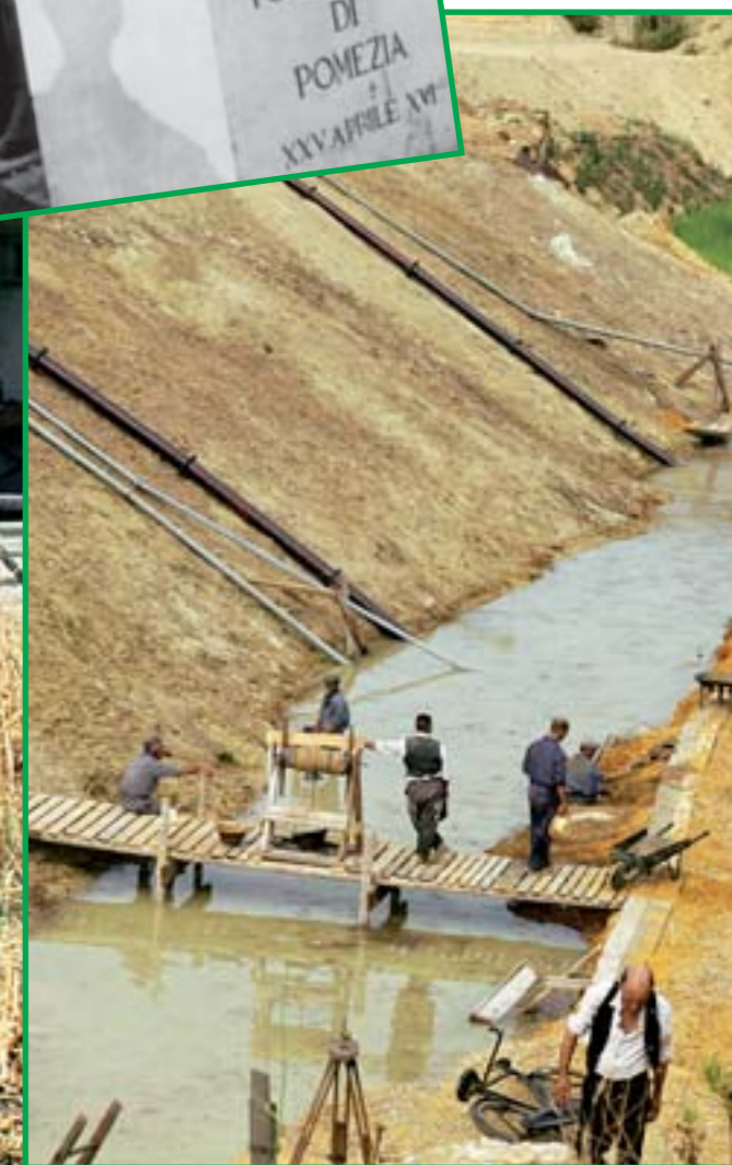
Un lavoro per tutti La bonifica della zona fu avviata con lo scopo di dare lavoro ai disoccupati, soprattutto reduci della Grande Guerra.
